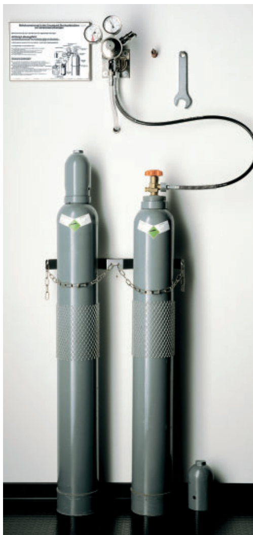
Richtig angeschlossene Kohlensäureflasche
